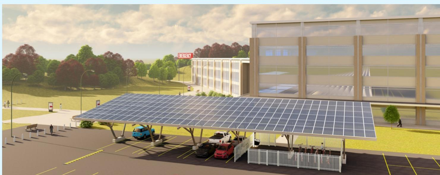
*Les auvents solaires inclinés combinent élégamment abri pour véhicules et production d'électricité, offrant une gestion de la pluie et de la neige qui va au-delà de la simple production d'électricité. Notez la fonction de recharge extérieure pour vélo électrique/MMAB. SOURCE : Groupe VCT <https://vctgroup.com>*
